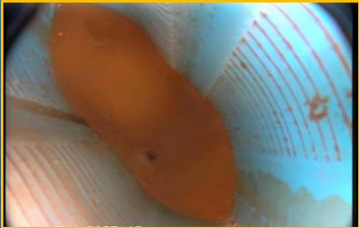
zusammengedrücktes Filterrohr DN 100 PVC
