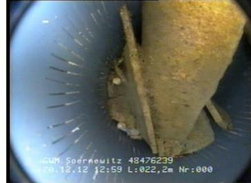
Aufundung im Filterbereich durch Fremdkörper
