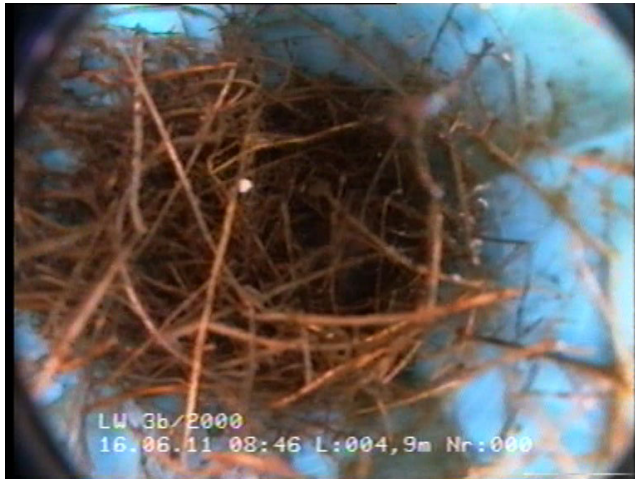
Abbildung 4: Wurzeleinwuchs
